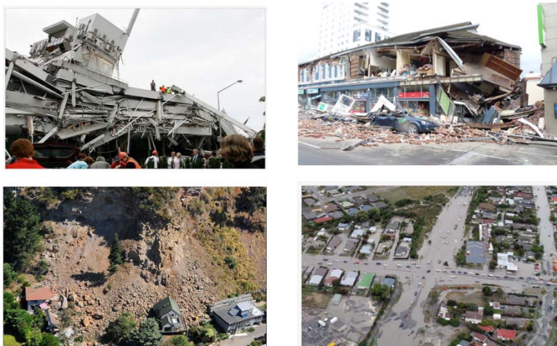
Abbildung 5: Typische Schadenbilder nach dem Magnitude 6,3 Erdbeben in Christchurch, Feb. 2011.
